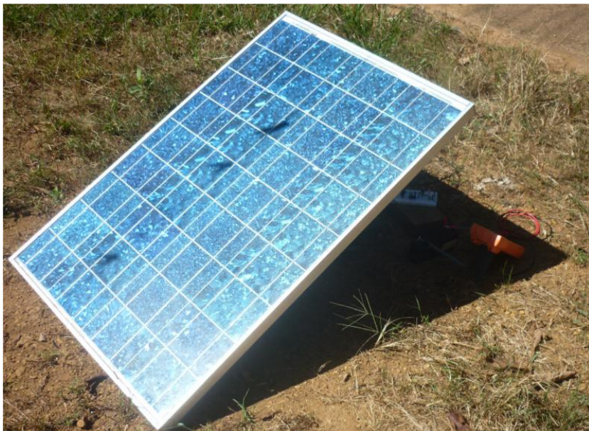
Figura 3. Realização do teste em campo com o carregador implementado.
